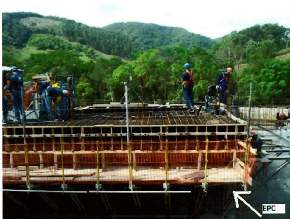
Figura 15b – Montagem das ferragens
