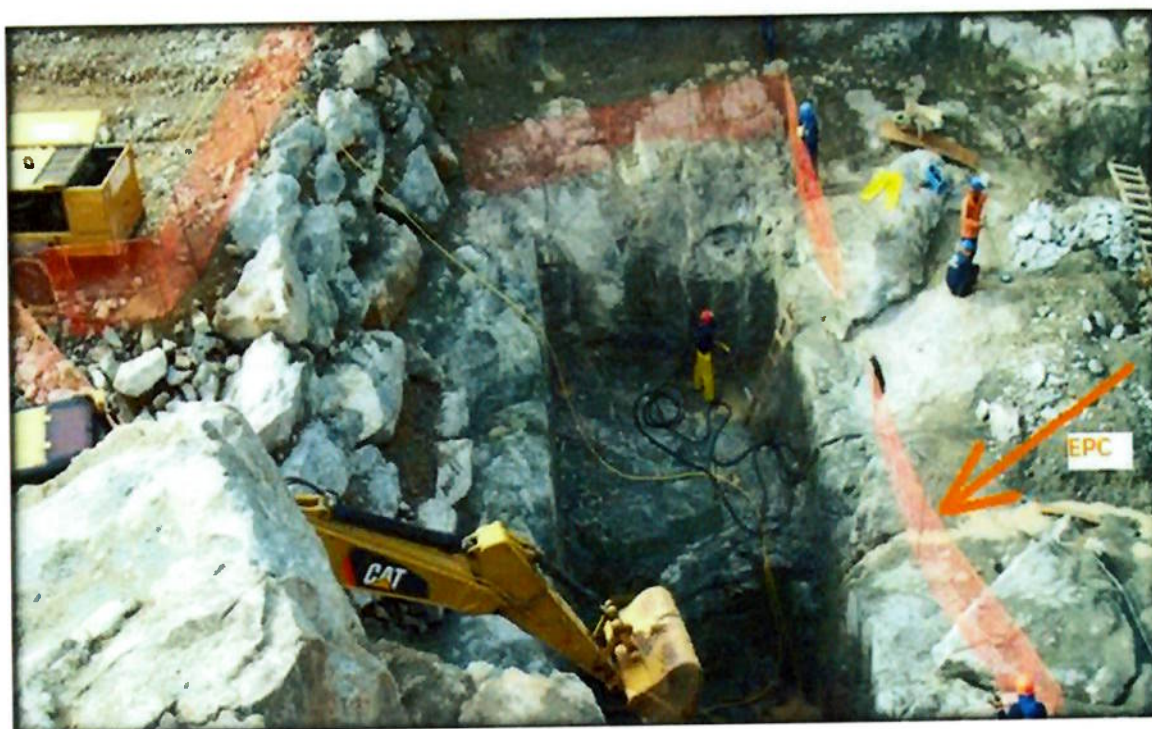
Figura 18 – Início das escavações da Casa de Força
