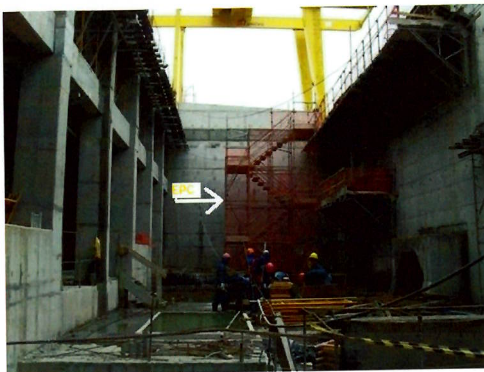
Figura 19 – Proteção contra queda e guarda- corpo da escadaria
